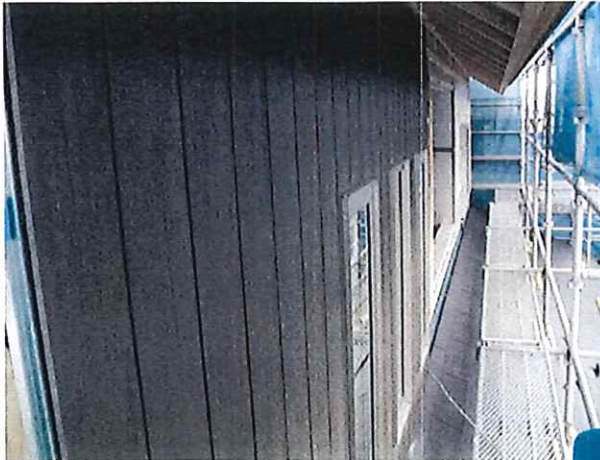
2階部分の外壁材の様子
